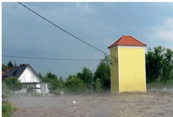
Abb. 9 Überflutete Transformatorstation
