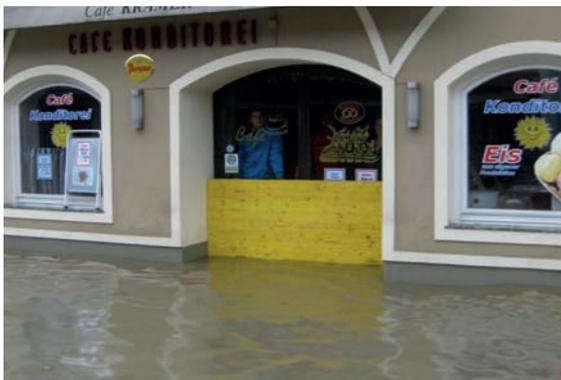
Abb. 7 Mobiler Hochwasserschutz
