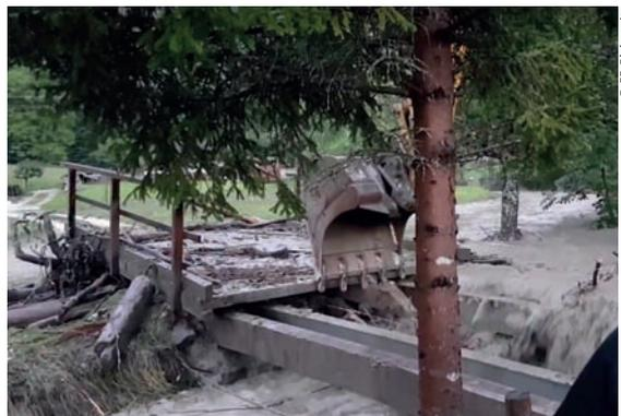
Abb. 6 Notmaßnahme - Entfernung der Brücke
