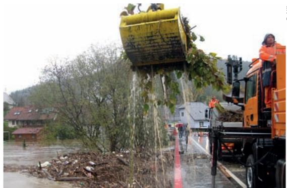
Abb. 5 Freihaltung des Abflussquerschnitts mittels Greifer
