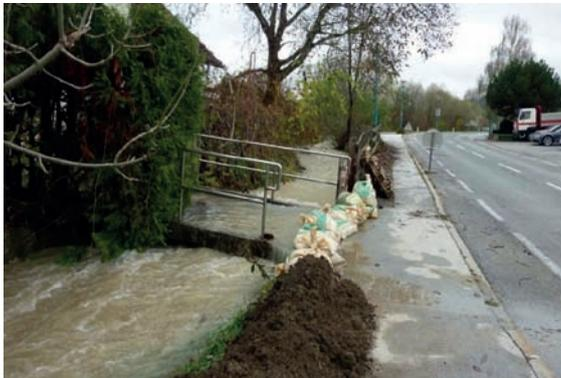
Abb. 8 Mobiler Schutz mit Sandsäcken
